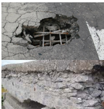
写真-1 凍害等によるRC床版の劣化・損傷
