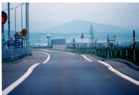
写真-2 泥炭性軟弱地盤上の道路の不同沈下
