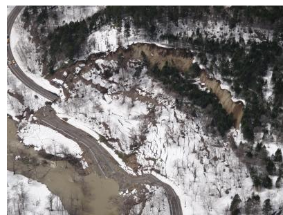
写真-3 融雪による地すべり
