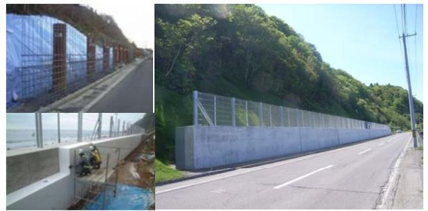
写真－4 杭付落石防護擁壁
