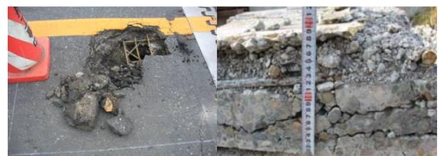
写真-9 RC床版の劣化損傷状況
