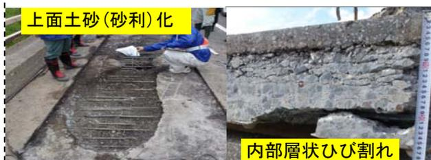
写真-13 RC 床版の劣化損傷状況
