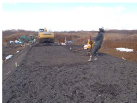
写真-4 アスファルト廃材の実物大の試験盛土
