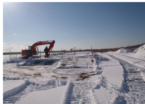
写真-3 冬期土工の様子
