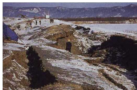
写真-1 泥炭地盤における河川堤防の地震被害事例
