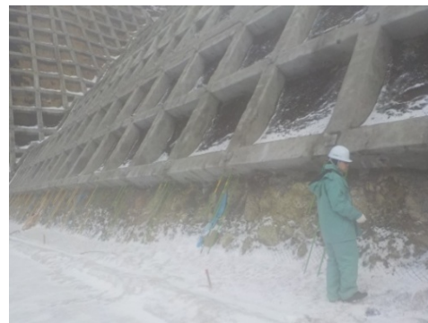
写真-2 試験施工箇所の調査
