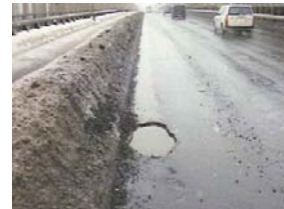
写真-4 ポットホール
