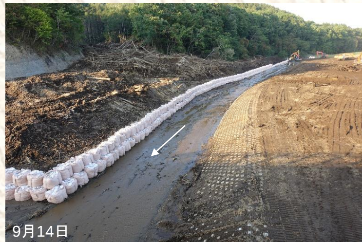
厚真川土砂撤去状況(幌内橋から上流を望む、上写真と同箇所)
