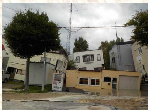
⑨車庫水没および住宅の傾斜
