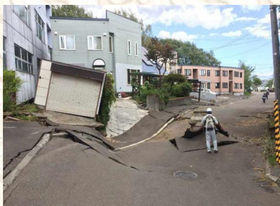
⑫住宅地での道路の陥没(道路沈下約1.5m、車庫傾斜)
