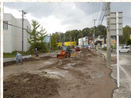
⑧旧国道36号での土砂排土状況
