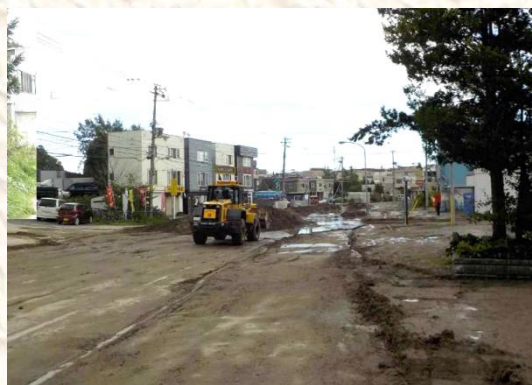
⑦北野里塚旧道線(旧国道36号)での 土砂排土状況
