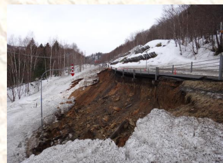
国道の盛土法面の崩壊
