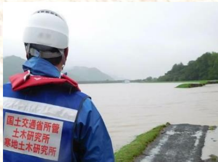
堤防越水・堤防一部流出
