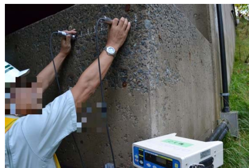
写真－４ 超音波（表面走査法）を用いた凍害診断
