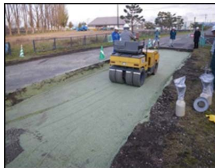
写真-3 ガラスカレットを用いた試験施工状況
