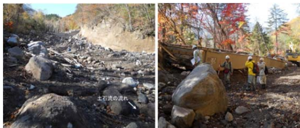
写真-13 恵庭岳における土石流の流下痕跡 (左)・流出した橋桁(右)
