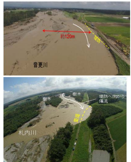
写真-5 大規模な河岸侵食による堤防決壊（音更川、札内川、2016年）
