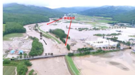
写真-1 空知川の破堤状況 (2016年)
