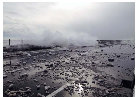
写真-4 沿岸道路の越波状況
