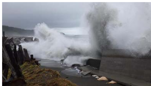
写真-2 海岸護岸の被災状況 (平成 27 年 8 月新ひだか町)
