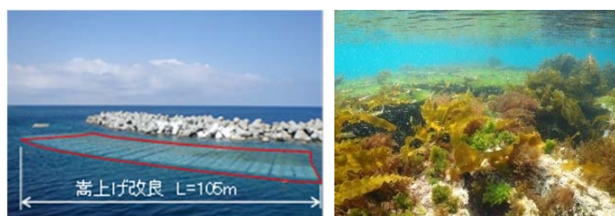
図-12 嵩上げ改良箇所と海藻繁茂状況
