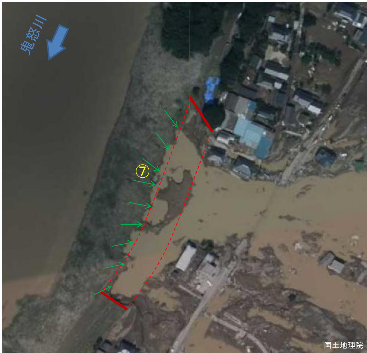
堤防決壊箇所の平面図. 緑線が植生倒伏方向.
