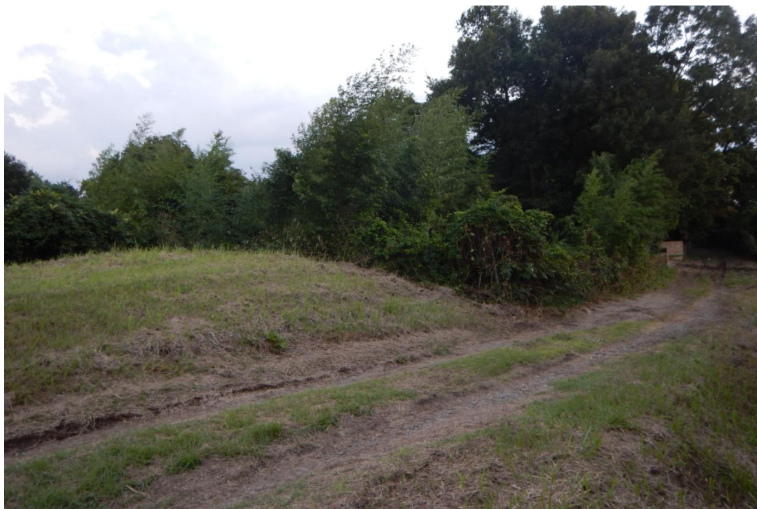
越水箇所より上流側 (写真左側が人工の堤防、右側が自然堤防)
