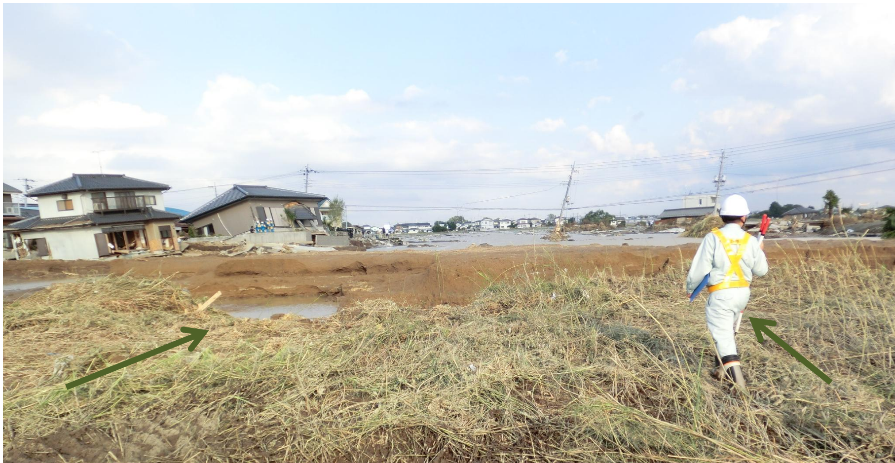
調査箇所⑦より堤内側を望む
