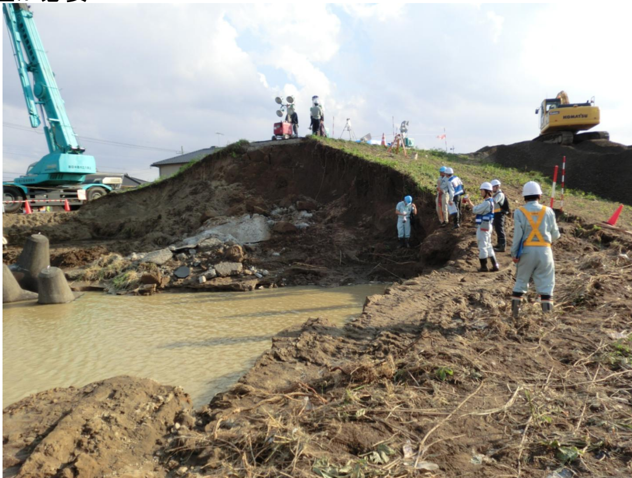
破堤下流端付近の深掘れ状況
