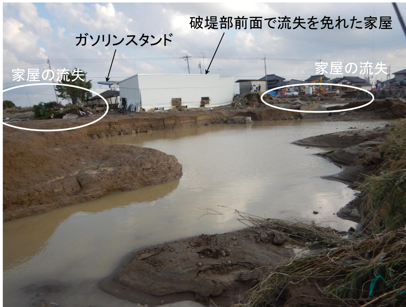
破堤箇所前面部の高水敷より堤内側を望む
