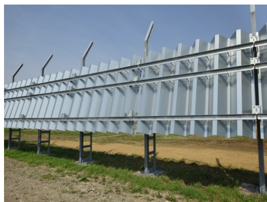
図-5 斜風対応可能な新型吹き払い柵
