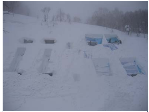
図-8 雪崩対策施設の現地試験の様子
