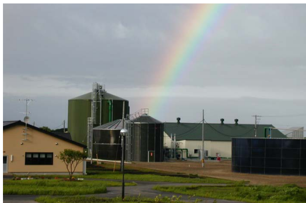
写真－２ 別海町の大規模集中型バイオガスプラント
