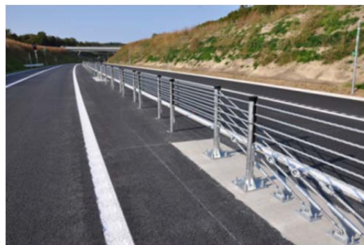
写真-4 ワイヤロープ式防護柵
