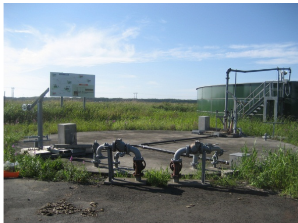
写真－３ 地下埋設型の曝気槽
