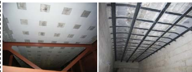
写真-11 炭素繊維を用いた床版下面補強例
