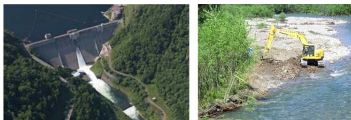
写真-10 札内川ダムフラッシュ放流と河道掘削（札内川礫河原再生事業、北海道開発局帯広開発建設部）
