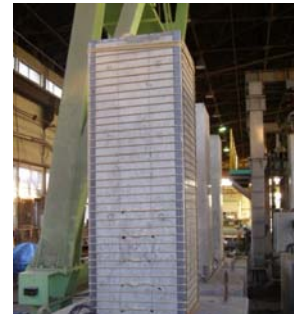
写真-8 アラミド繊維ロープ補強
