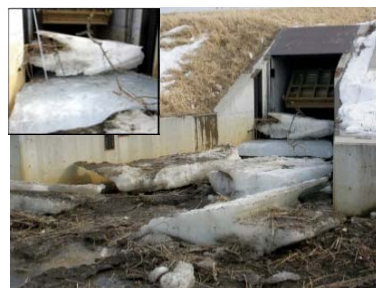
写真-6 氷板漂流物による樋門ゲート閉塞（十勝川、2011年）
