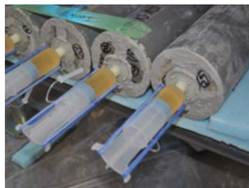
写真-1 樹脂系注入材を用いたひび割れ注入工法
