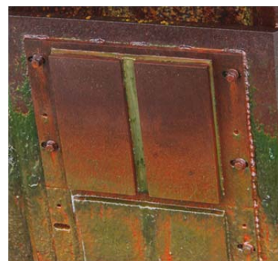
写真-5 犠牲鋼板暴露試験体の状況(3年目、2016年流水離岸後)
