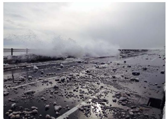
写真-4 沿岸道路の越波状況
