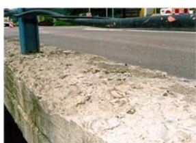
写真-1 スケーリング
