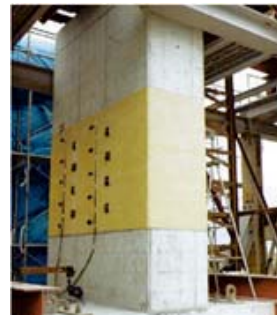
写真-7 アラミド繊維シート補強
