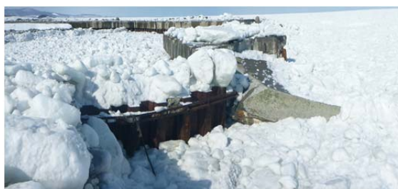
写真-3 オホーツク海に面した構造物の損傷例
