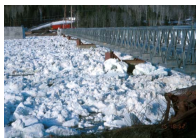
写真-8 橋脚周辺のアイスジャム
