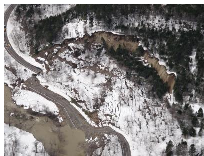
写真-3 融雪による地すべり
