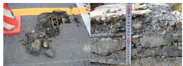
写真-9 RC床版の劣化損傷状況
