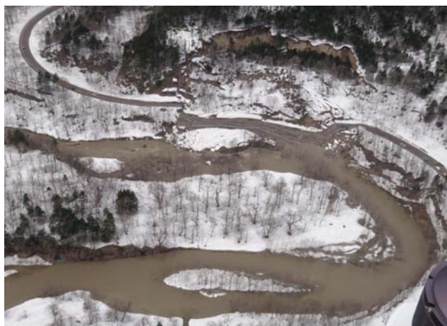
写真-2 霧立峠融雪地すべり
