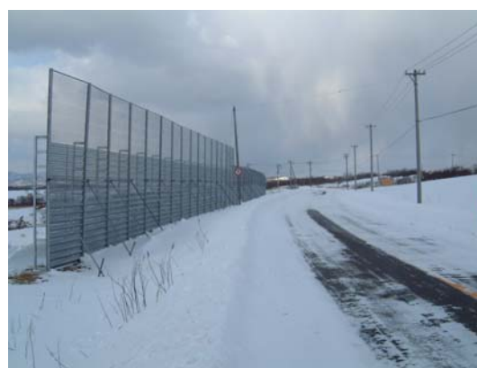
図-6 高盛土対応型の高機能防雪柵
