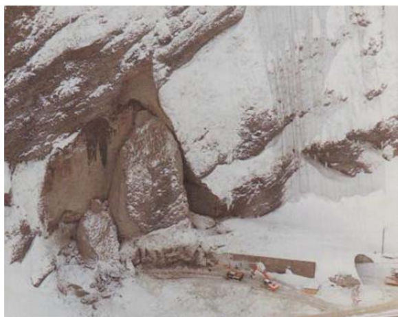
写真-1 豊浜トンネル崩落事故
