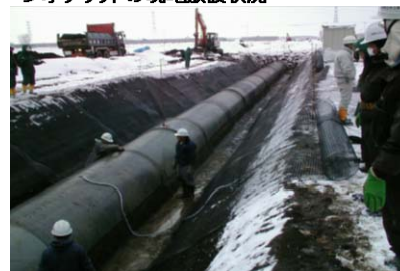
図－1 泥炭地におけるジオグリッドを用いた管の施工
