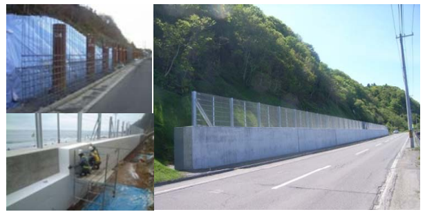
写真－4 杭付落石防護擁壁
