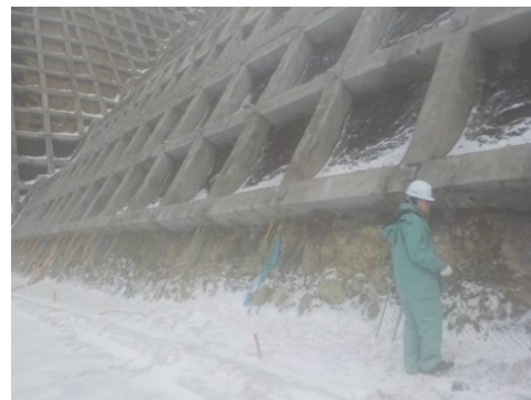
写真-2 試験施工箇所の調査
