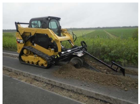
写真－5 電線類埋設用トレンチャーの掘削試験状況
