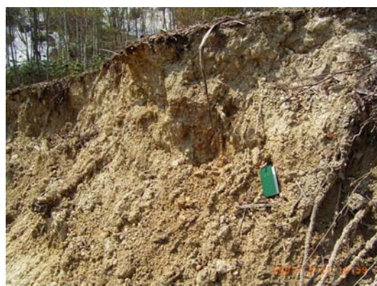
写真-2 風化した凝灰岩
