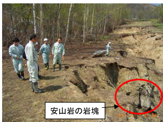
写真-1 崩壊地の状況
