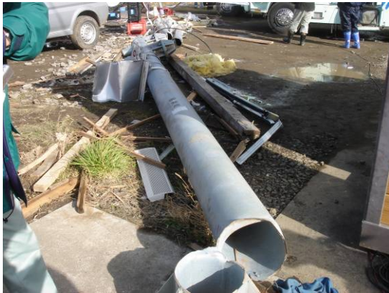
倒壊したF型標識柱
