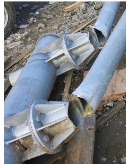
F型標識柱 梁基部
