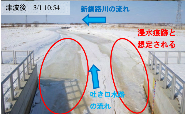
写真-7 新釧路川 KP4.5 付近 愛国樋門 吐き口水路
