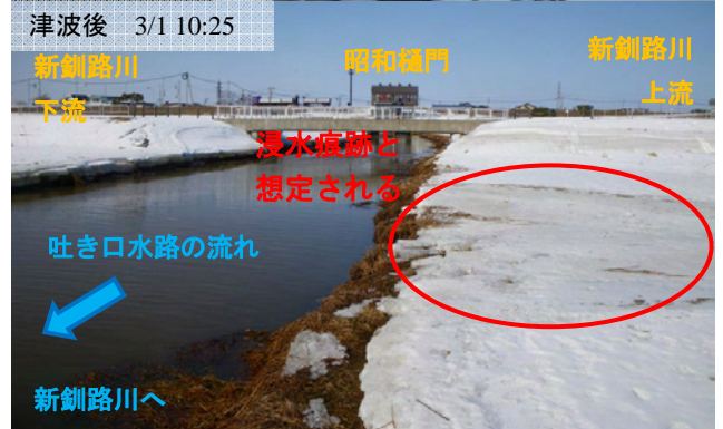
写真-5 新釧路川 KP2.8 付近 昭和樋門 吐き口水路
