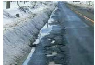
融解期の舗装の損傷例
