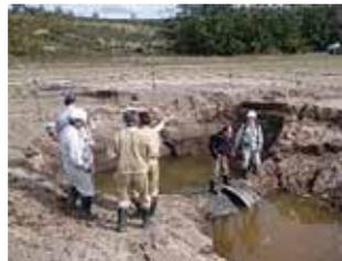
地震災害により被災した農業用管水路
