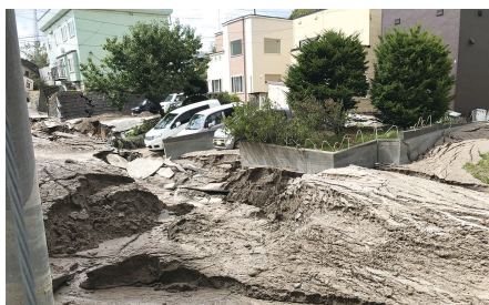
火山灰質土による 谷埋め盛土の液状化被害
