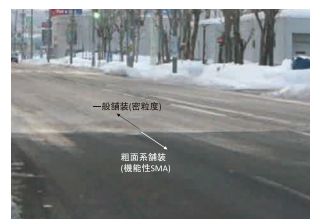
機能性SMAの冬期路面時の状況例
