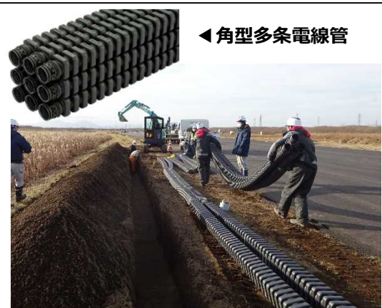
▲角型多条電線管の採用 (令和2年度 寒地土木研究所試験施工)
