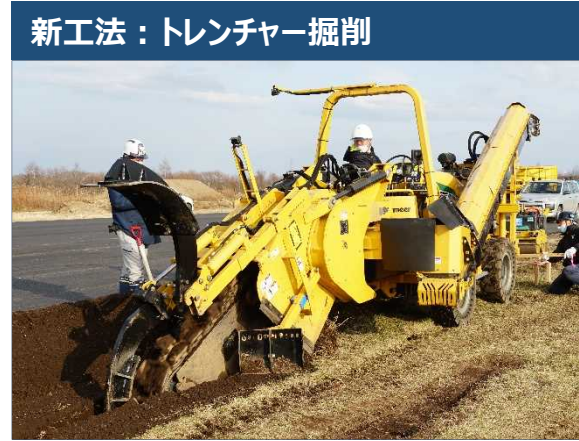
▲トレンチャー掘削の状況 (令和2年度 寒地土木研究所試験施工)
