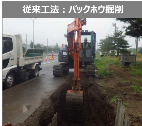
▲バックホウ掘削の状況
