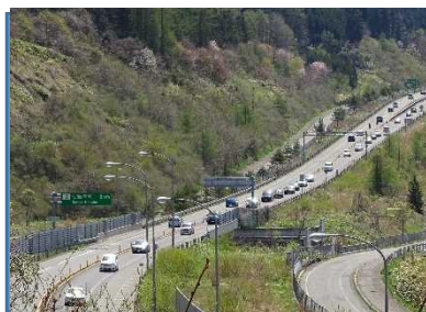
▲ E5 函館新道 函館と道央圏を結ぶ高規格道路
