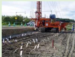
対策事例：圧密促進工法（プラスチックドレーン工法）
