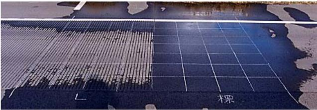
写真1 排水機能比較 右:グルーピング 左:一般舗装
