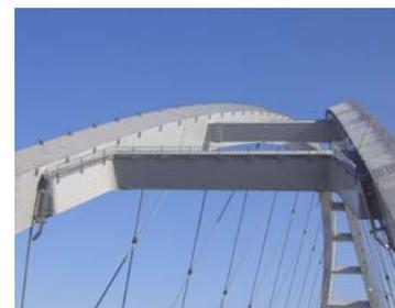
写真2 実橋に設置された格子フェンス
