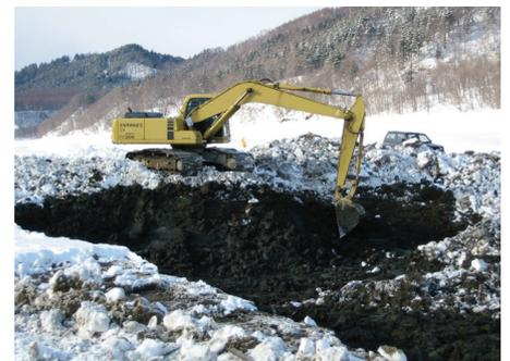
写真 凍結した底泥土の採取
