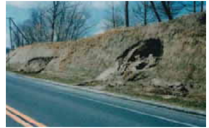
融雪期における切土のり面の崩壊
