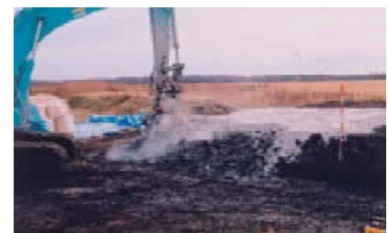
泥炭と固化材の混合
