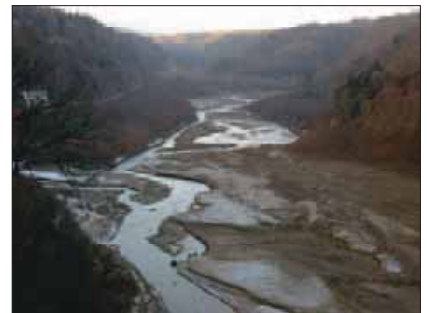
堆砂が進行した結果、カビ臭発生原因である放線菌の増殖が進んだ漁川ダム
