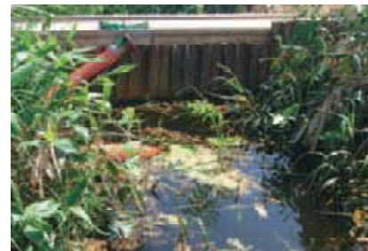
写真-2 附帯明渠の堰上げ
