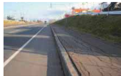
写真-1 歩道の凍上被害の例
