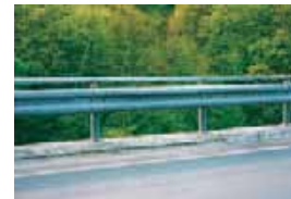
写真-1 スケーリング劣化事例
