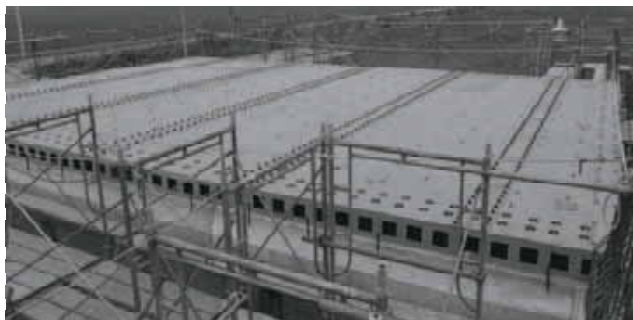
現地施工状況
