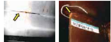
鋼床版の損傷事例
