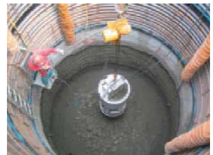
深礎杭のモルタルライニング施工
