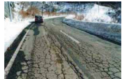
写真-1 凍上被害を受けた路面例
