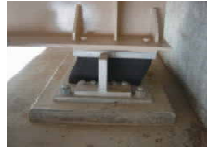
液状化による橋台の側方移動に伴う支承の変形
