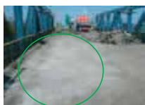
実橋床版の劣化状況
