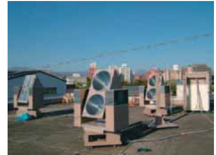
自動追尾機能付き太陽熱収集装置
