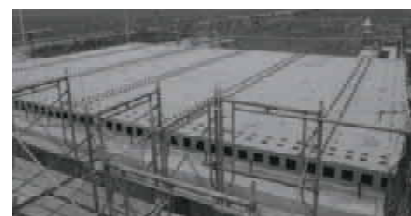
試験フィールド事業による複合函渠の施工状況
