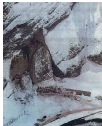
豊浜トンネル崩落事故
