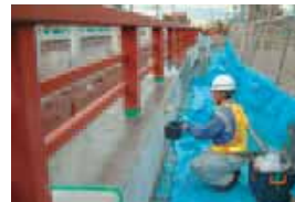
写真-2 試験施工状況(美幌橋)
