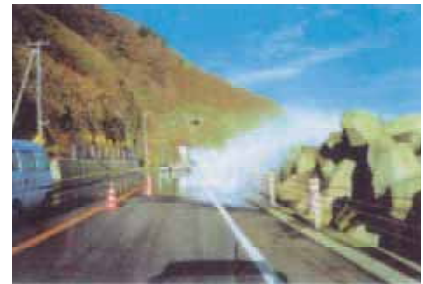
道路護岸における越波の例
