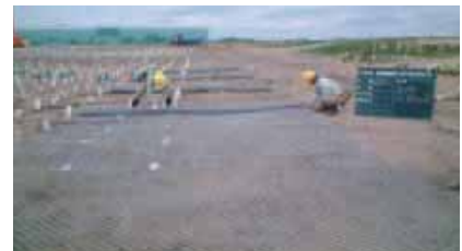
敷き網併用プラスチックドレーンの施工
