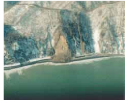
H16年 えりも岩盤崩落
