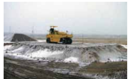
冬期盛土施工状況
