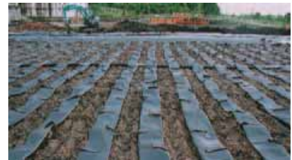
真空圧密工法の施工
