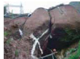
現場における岩体の不安定化実験
