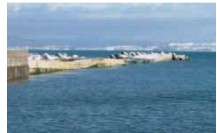
吸出しによる港湾構造物の沈下被災例
