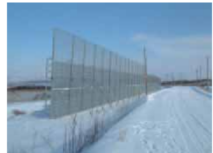
写真-2 高機能防雪柵(高盛土対応型)の実験状況
