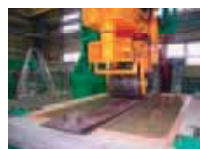
水張り試験状況
