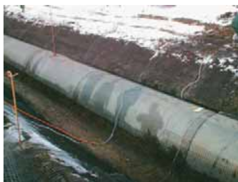
ジオグリッドによる泥炭地埋設管路
