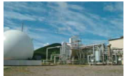
バイオガスプラント
