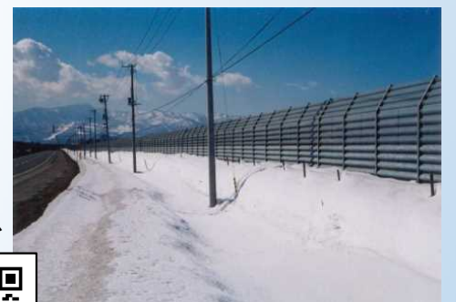
防雪柵（吹き止め柵）設置状況
