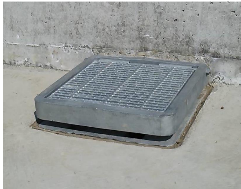
現地設置状況
