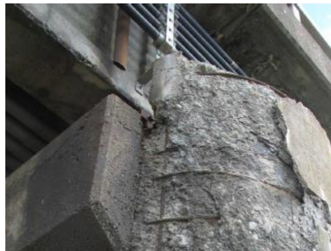
橋台・橋脚の劣化損傷(凍害・塩害)
