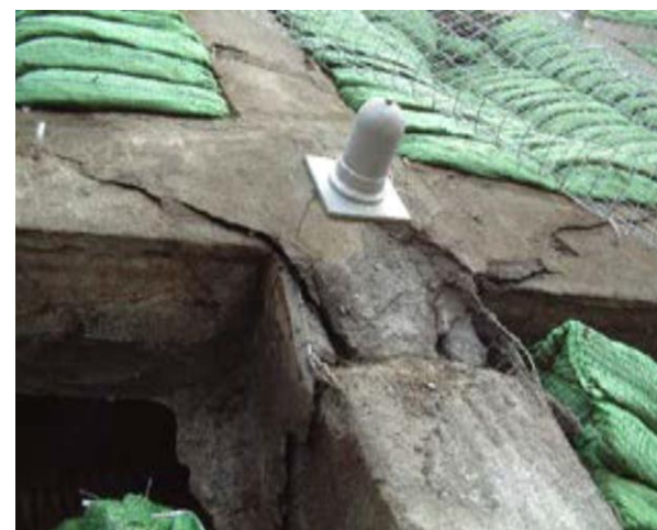
のり面小段排水溝やコンクリート法枠の凍上 (切土のり面)
