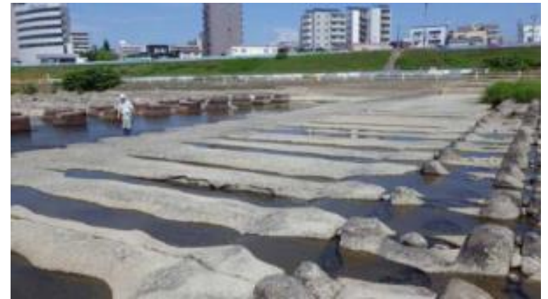
波浪・流水摩耗による複合劣化 (沿岸構造物)
