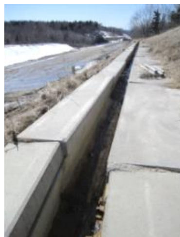
のり面小段排水溝やコンクリート法枠の凍上 (切土のり面)
