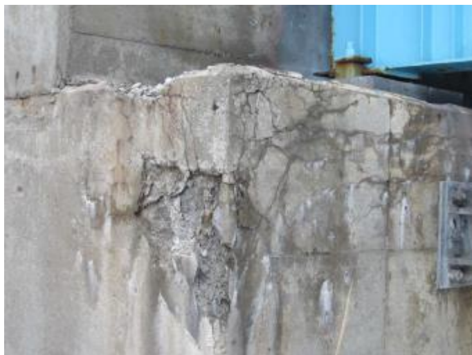
橋台・橋脚の劣化損傷(凍害・塩害)
