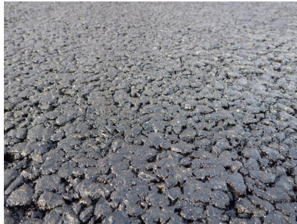
施工後の路面状況
