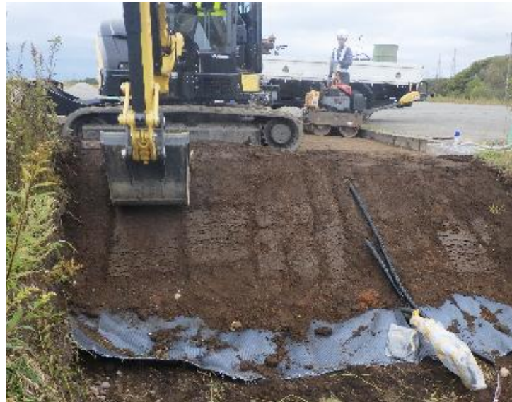
試験施工状況
