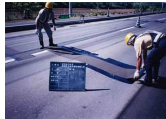
シート工法の施工状況 (低温クラック箇所)
