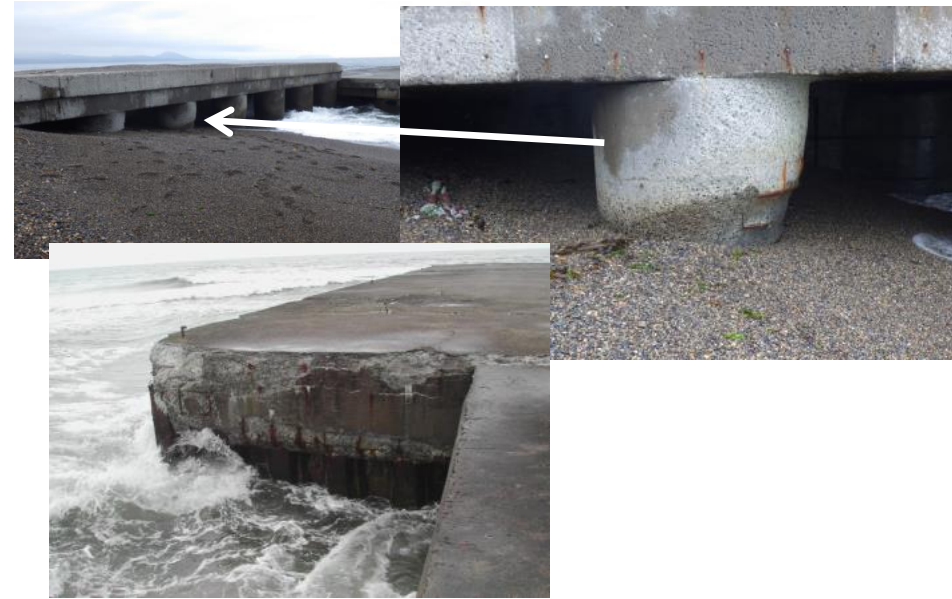
波浪・流水摩耗による複合劣化 (沿岸構造物)
