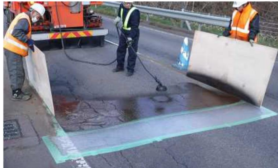
エンジンスプレーヤによる 施工状況
