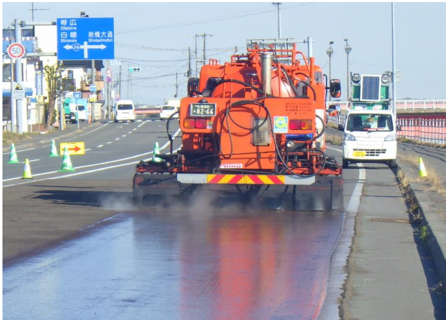
フォグシール散布車による 施工状況
