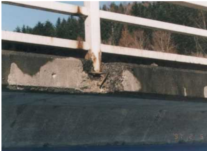
高欄支柱の露出
