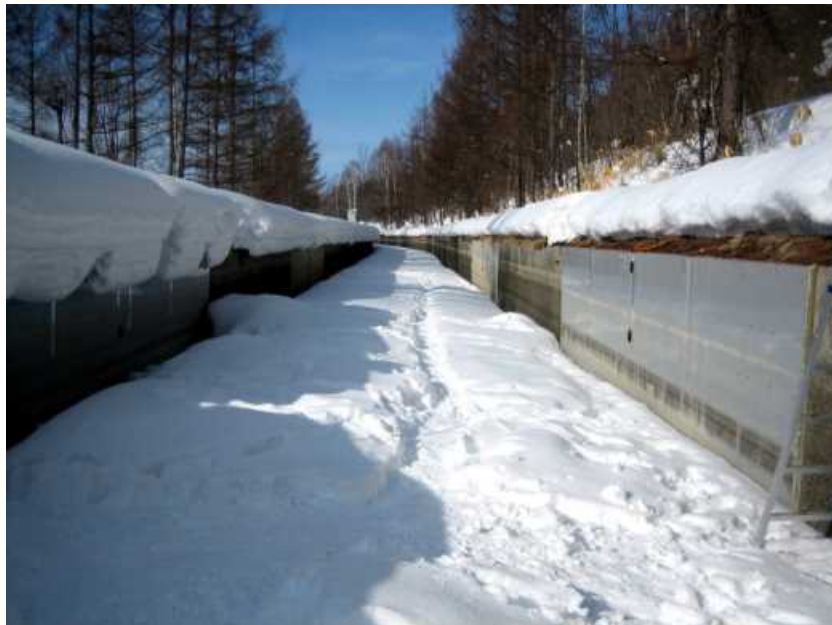
冬期間の試験施工区間の状況
