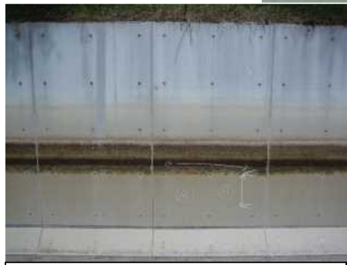
機能を保持し続ける FRPM板 (施工11年目の状況)
