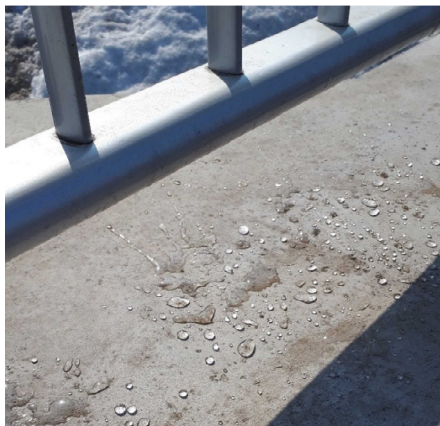
部材表面に水を噴霧した様子
