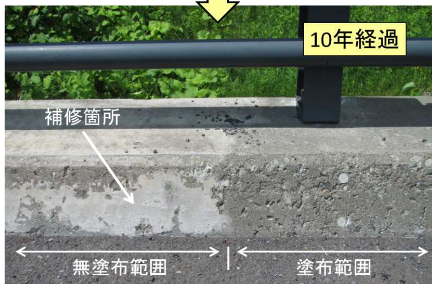
道央地方山間部の道路橋地覆
